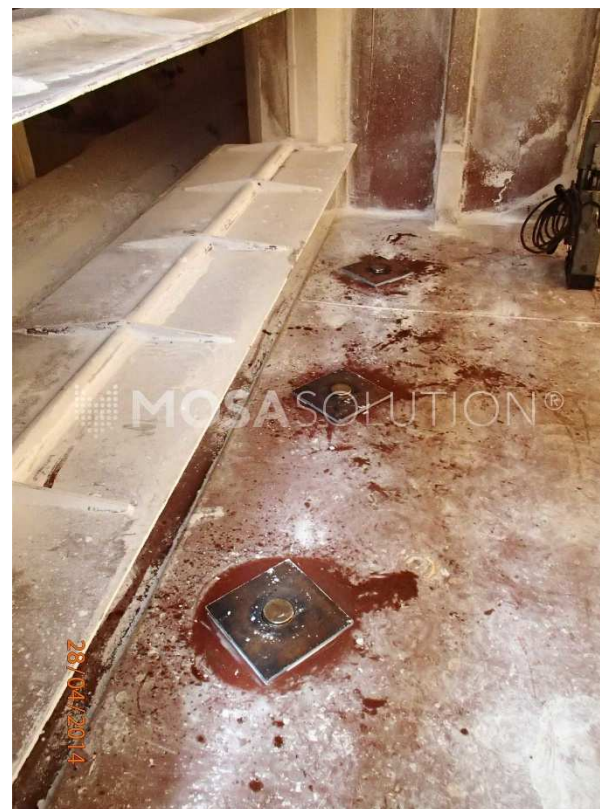
Montáž pulzních trysek Myrlen®
