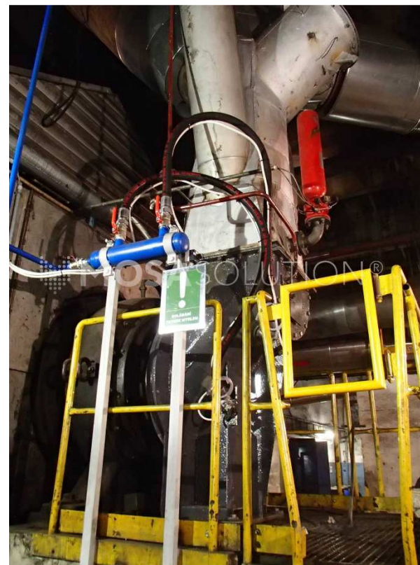
Montáž pulzních trysek Myrlen ®
