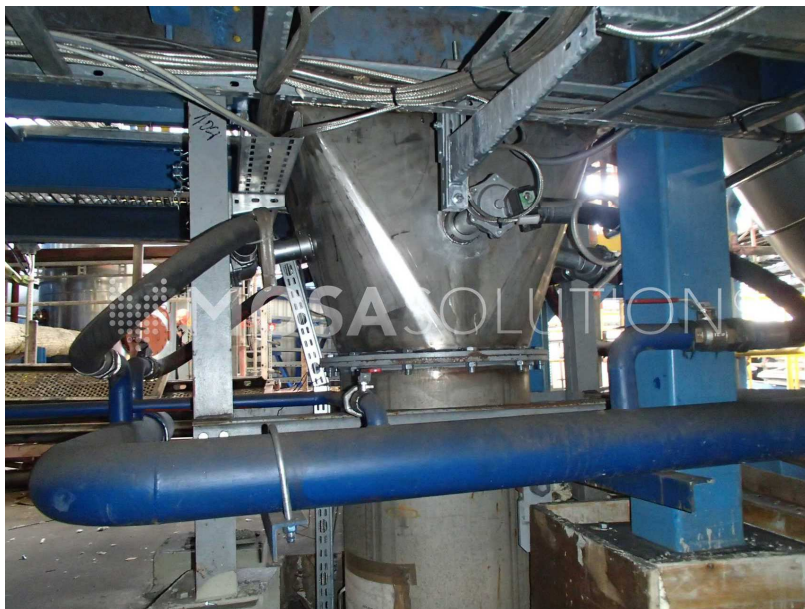
Montáž pulzních trysek Myrlen ®
