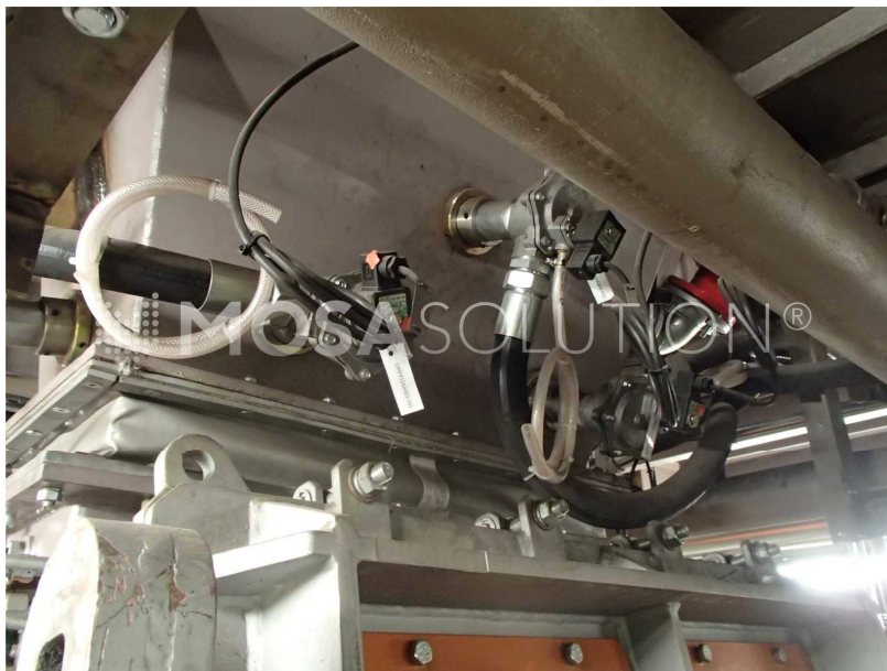
Montáž pulzních trysek Myrlen ®
