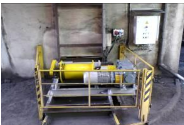
Vrátek EVV1 po modernizaci
