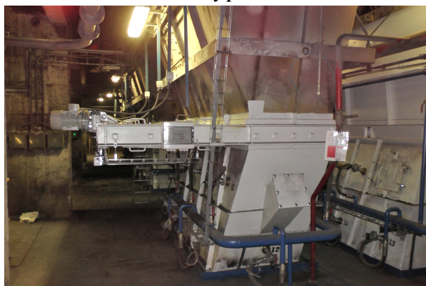
Obr. 11.: deskové uzávěry po instalaci
