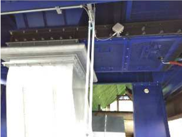
Obr 3.: Instalace dolního DU 950-1050-HP
