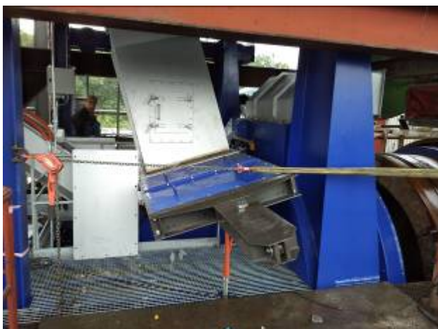
Obr 2.: Instalace horního DU 900-1000-HP
