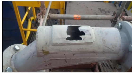
Obr. 9 Netěsnost na potrubí pseudopravy
