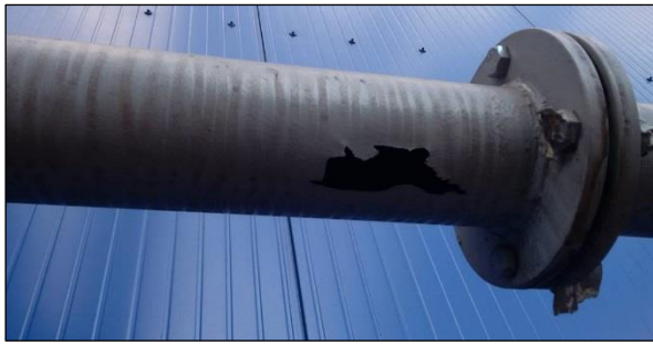
Obr. 8 Netěsnost na potrubí pseudopravy
