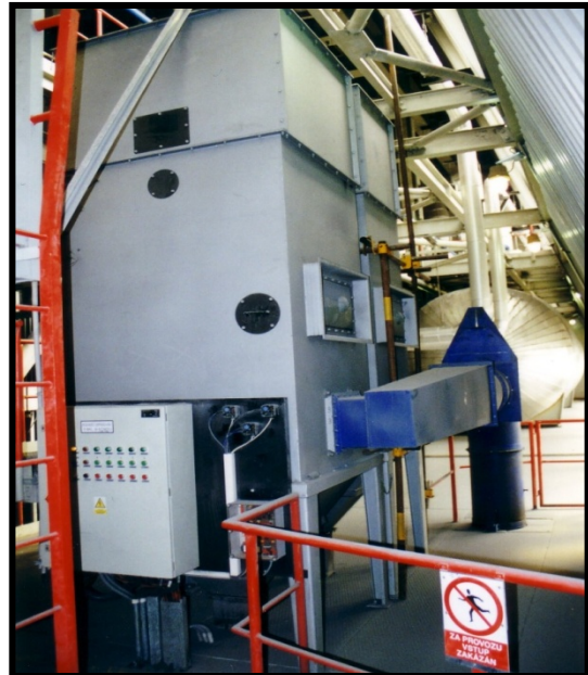
Obrázek č. 4: Příklady špatné aplikace zařízení na uvolnění výbuchu
