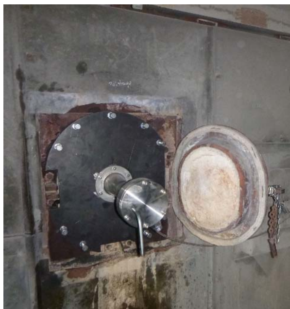
Obrázek 8 a 9 – Namontovaný akustický měnič před zaizolováním a pohled na čištěnou technologii [1]
