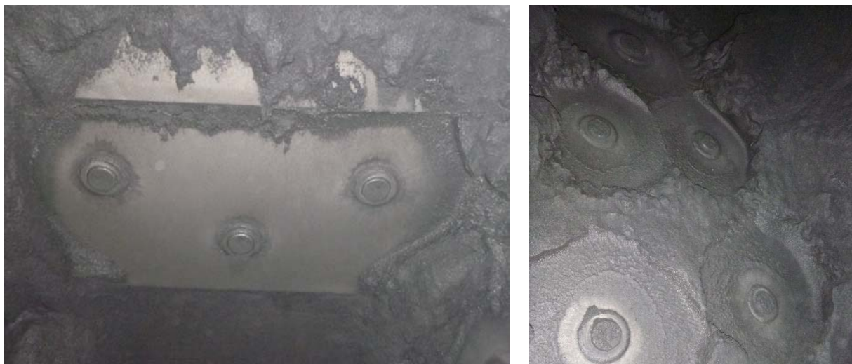
Obrázek 13 a 14 – Garantovaný tok uhlí za pomoci pulzních trysek Myrlen® [1]
