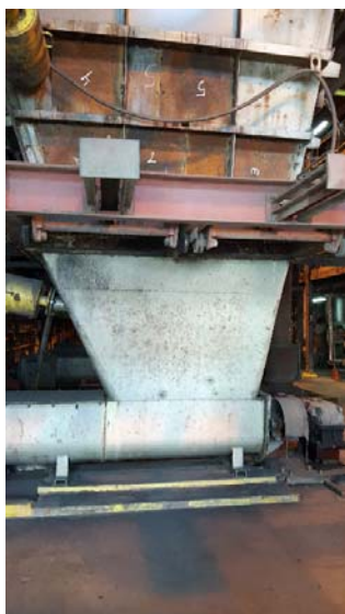
Obrázek 2 a 3 – Svod do šnekového dopravníku a důsledky mechanického obouchávání [1]
