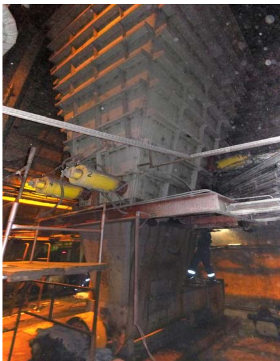
Obrázek 1 – Pohled na zásobník uhlí se vzduchovými kanóny [1]
