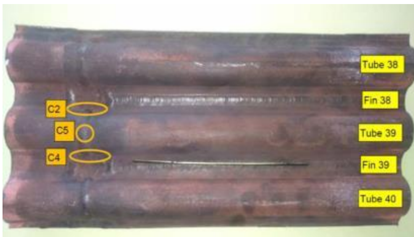
Trhliny z neotopené strany
