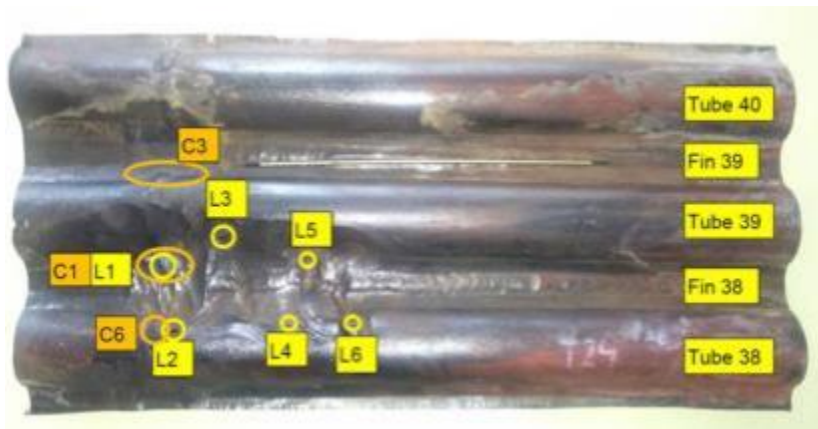
Trhliny z otopené strany (spalin)
