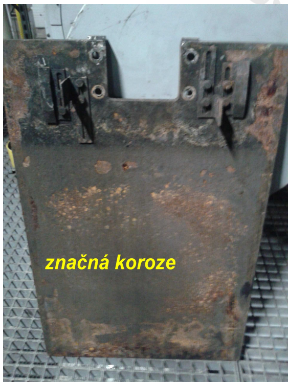
Obrázek č. 10.: zkorodovaná uzavírací deska DU z běžné oceli ve velmi vlhkém prostředí
