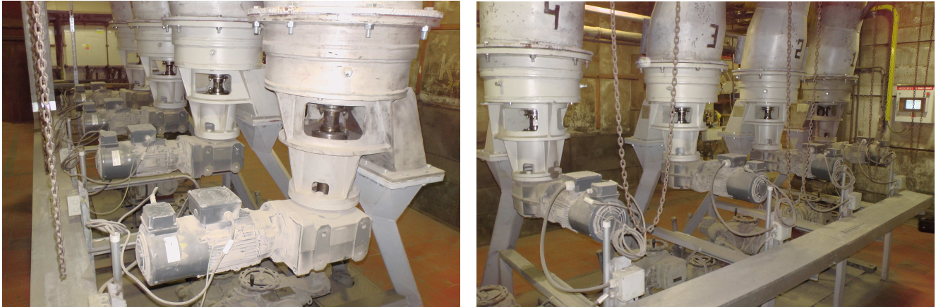
Obrázek č. 2., 3.: Instalace v provozu, Teplárna Karviná, kotel K3
