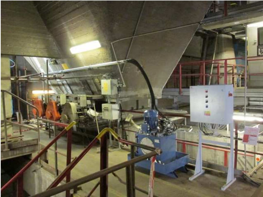
Obrázek č. 4.: Hydraulická a řídicí jednotka systému rozrušení klenby dřevní štěrky
