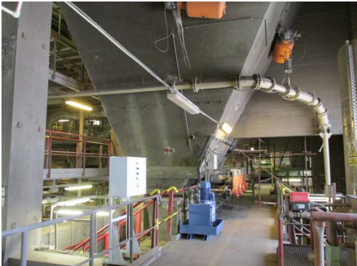
Obrázek č. 3.: Jeden ze zásobníků uhlí FK1 upravený pro dřevní štěpku
