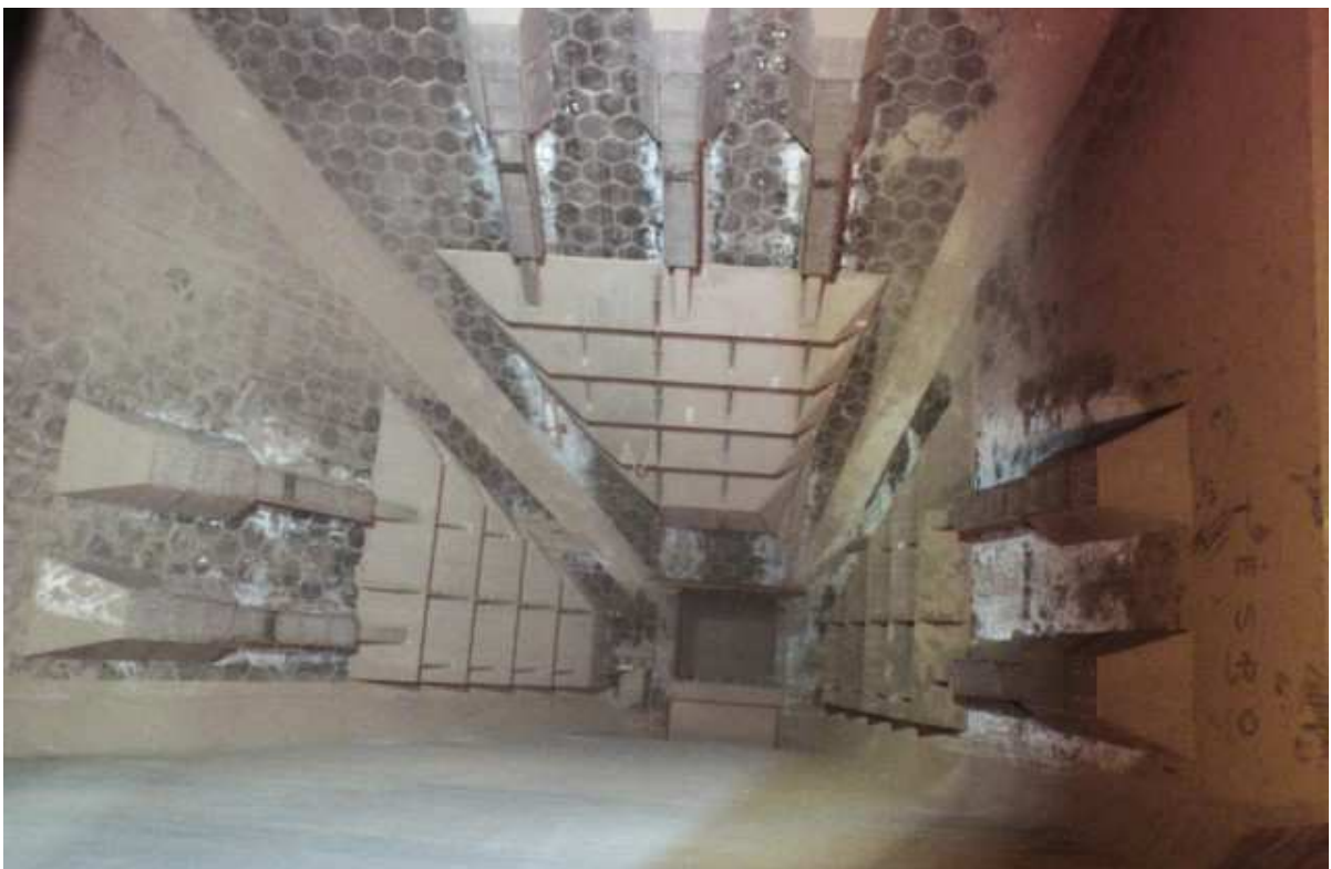
Obrázek č. 2.: Rozrušovací hrabla namontovaná do zásobníku uhlí pro FK1
