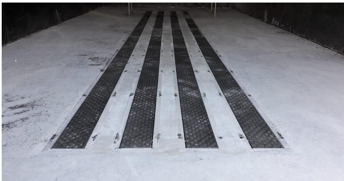
Obr. č. 4 Uspořádání provzdušňovacích žlabů v BEWA boxech společnosti RPS Ostrava a.s., T+T Hričov, Slovensko
