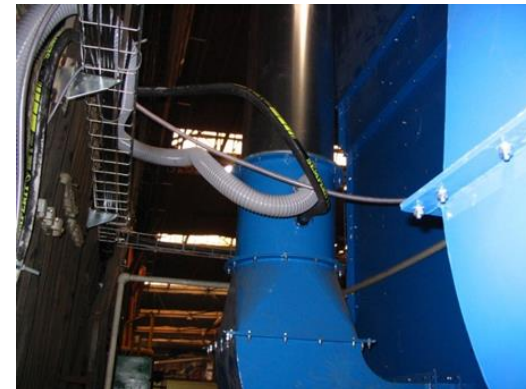
Obslužné plošiny filtračních jednotek
