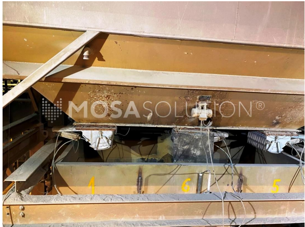
stávající ocelový zásobník s výsypy do technologie míchání
