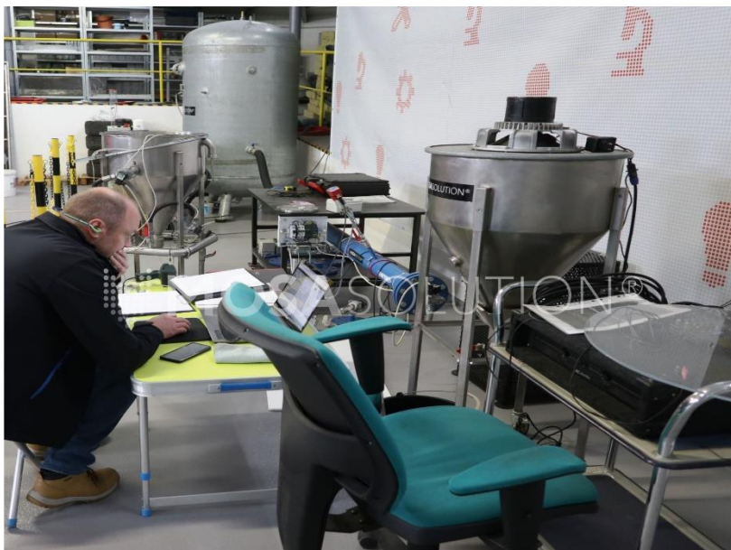
měření tlakového vzduchu na zkušební potrubí
