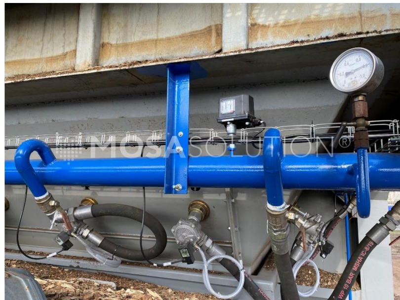
montáž pulzních trysek Myrlen® ve výsypné části
