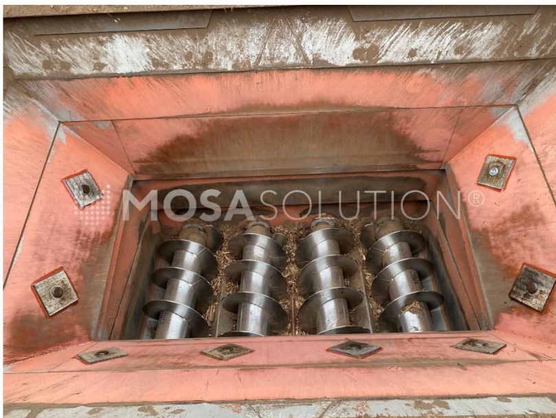
rekonstrukce zásobníku se šnekovými podavači
