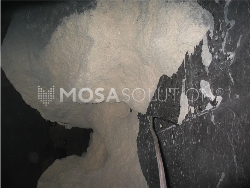
klenba a tunel v ocelovém zásobníku s pilinami
