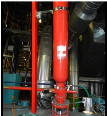
Obrázek č. 11: Instalace HRD systémů a HRD barier na dílčích částech mlýnského okruhu ve společnosti TEKO a.s. Košice
