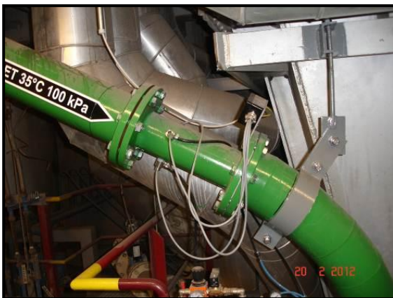
Obrázek č. 7: Instalace rychlouzavíracího šoupěte DN 125 s detekcí na pseudoprově do kotle FK2
