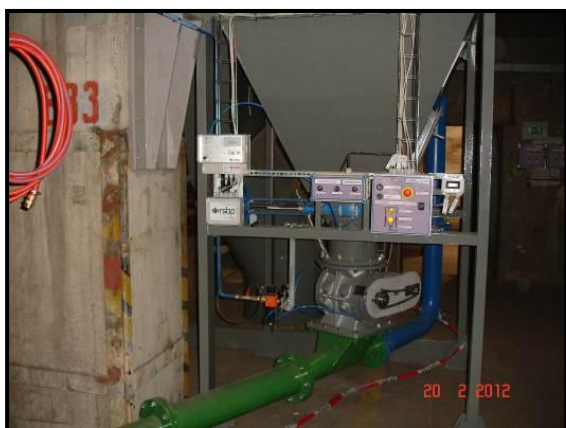
Obrázek č. 8: Instalace HRD systému na potlačení výbuchu na zásobníku peletek, včetně oddělení výbuchu na výstupu z tohoto zásobníku
