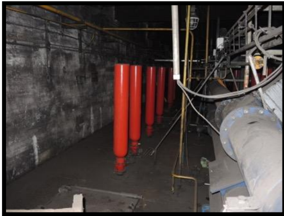
Obrázek č 10: Instalace HRD systémů a HRD barier na dílčích částech mlýnského okruhu
