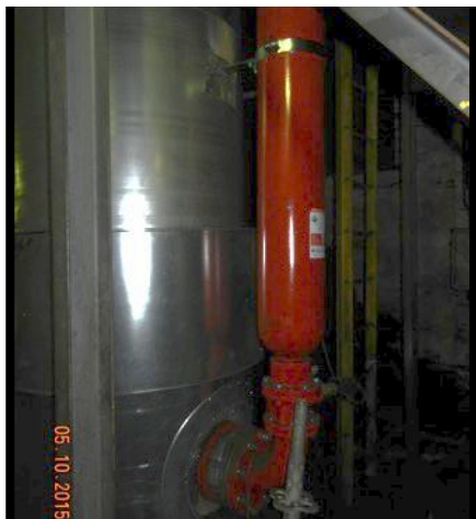
Aplikace č. 3 – Instalace ochrany před výbuchem technologie mletí v TEKO a.s. Košice (SK)
