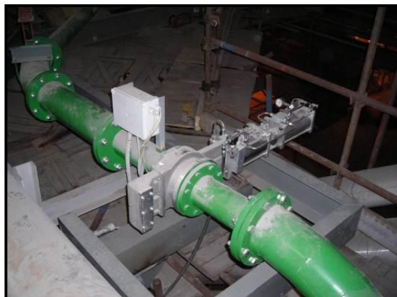
Obrázek č. 7: Instalace rychlouzavíracího šoupěte DN 125 s detekcí na pseudoprově do kotle FK2
