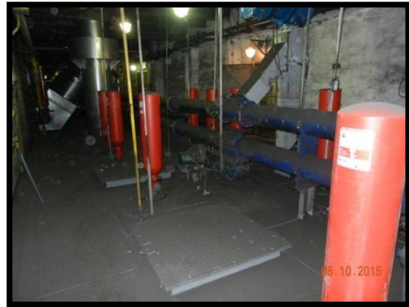
Obrázek č 10: Instalace HRD systémů a HRD barier na dílčích částech mlýnského okruhu
