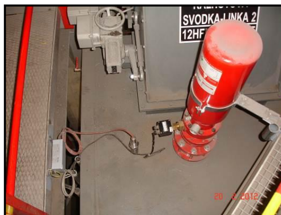
Obrázek č. 8: Instalace HRD systému na potlačení výbuchu na zásobníku peletek, včetně oddělení výbuchu na výstupu z tohoto zásobníku
