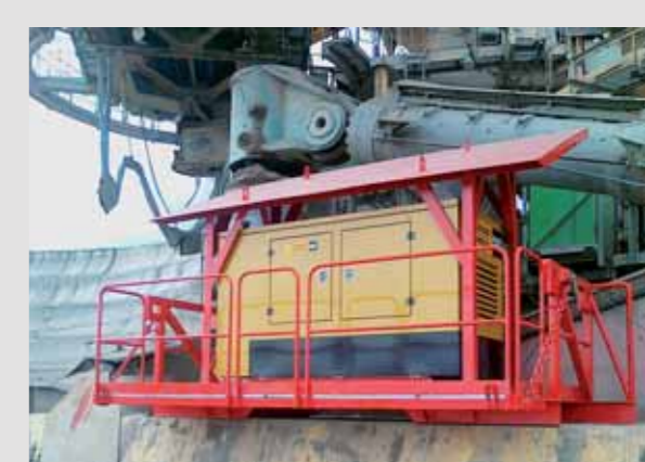
Dodávka diesel agregátu na KU 800.18/K99 Výroba a montáž rámu pod diesel agregát
