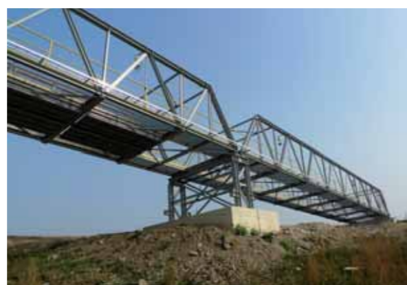
Lávka PD 704 Ocelová konstrukce lávky pro pasovou dopravu
