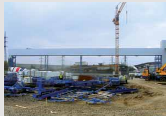
Ocelová konstrukce pod drtič Ocelová konstrukce drtiče.
