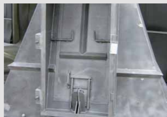
Obnova drtiče D15 – dodávky IP 2 a 6 Repase a výroba nových dílů drtiče D15.
